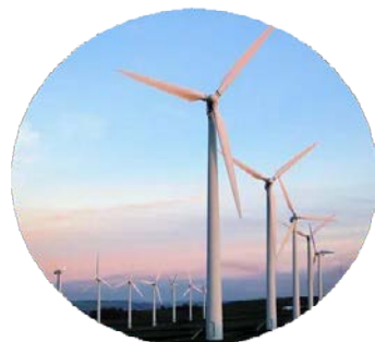
Жел электр станциясы 45 МВт Балқаш
