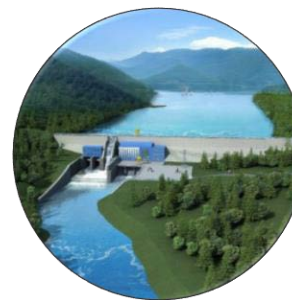
ШҚО-да 27,4 МВт су электр станциясы
